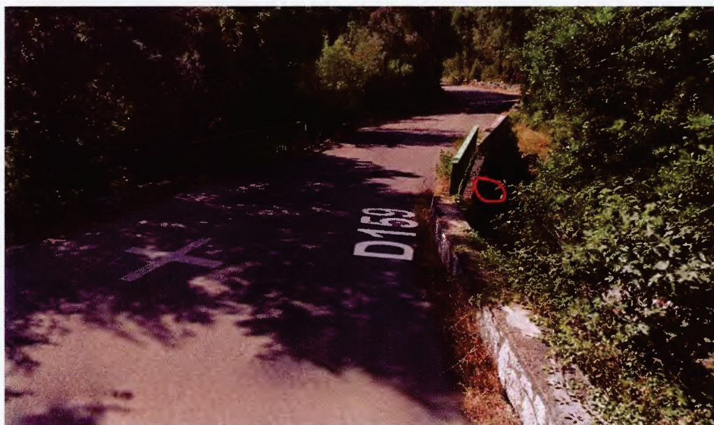
2- Pont de Palavaghja
