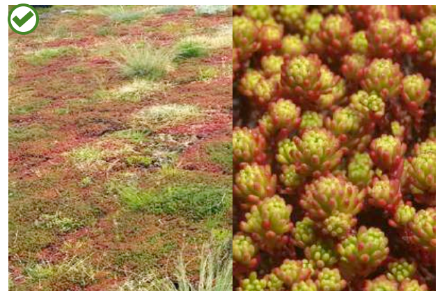
Toiture plantée de sedum et graminées - substrat 5 à 10cm
