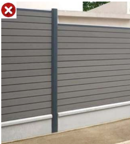
Panneaux soudés sur mur maçonné
