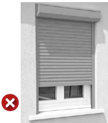
Les volets roulants et caissons apparents en PVC
